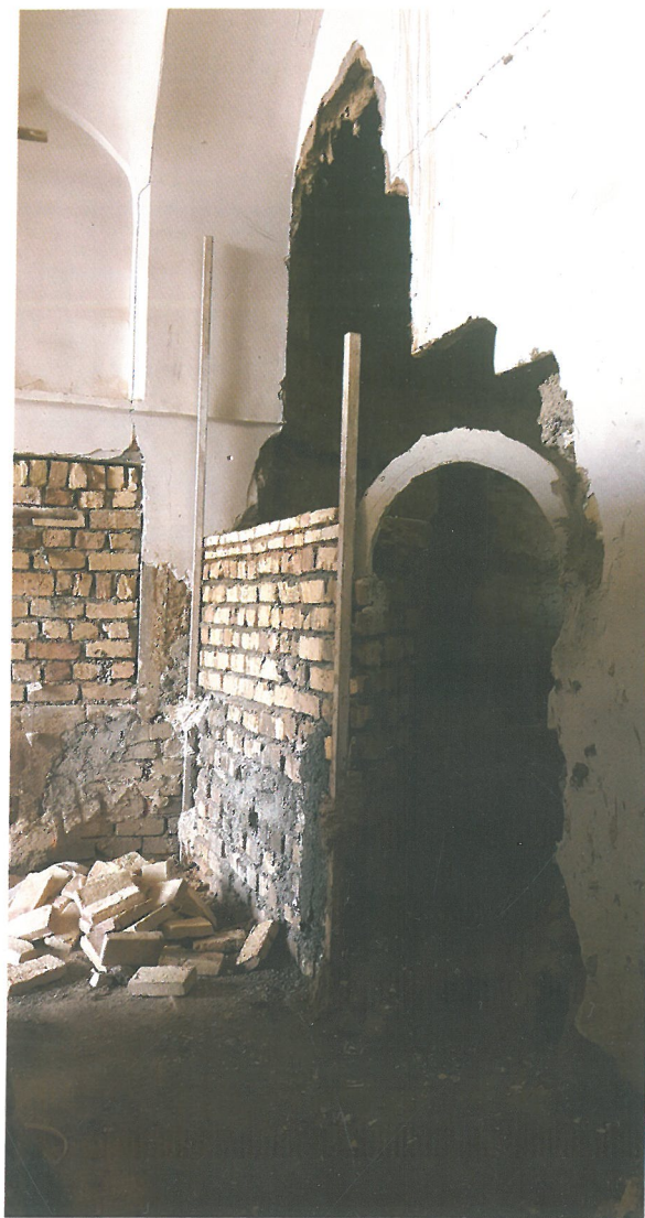
ایجاد در جدید کوره و ساخت حمام از فضای اتاق برای اتاق Making a new kiln door and building a bathroom for the room within the room space
