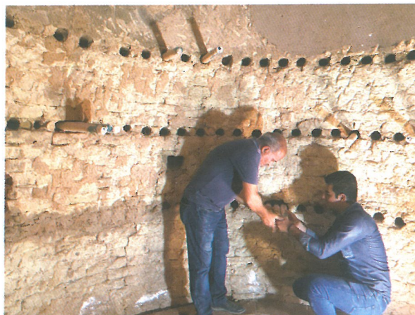
قراردادن میخ‌های سفالی به عنوان طبقه در کوره به صورت متصل به هم و منفرد Inserting the earthenware bars as shelves in the kiln individually and continuously
