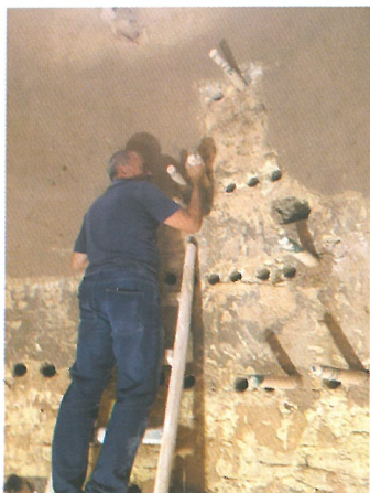
قراردادن میخ‌های سفالی به عنوان طبقه در کوره به صورت متصل به هم و منفرد Inserting the earthenware bars as shelves in the kiln individually and continuously
