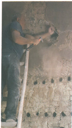
پیدا کردن سوراخ دوم فوقانی هواکش Finding the second upper vent of the air vent
