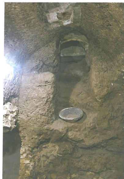
نمایی از بخش جانبی آتش‌دان جهت انتقال هوا به زیر آتش‌دان A side view of the fireplace for transmission of air to the fireplace
