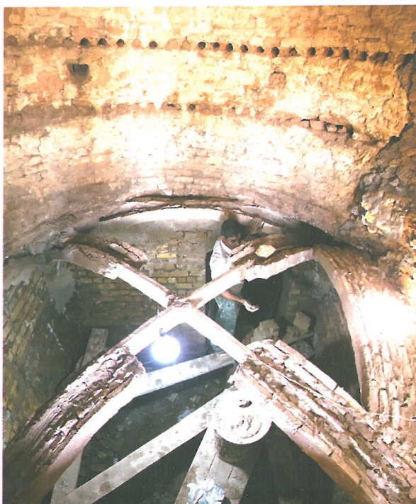
ساخت سقف آتش‌دان بر اساس الگو Building the fireplace ceiling on the basis of the model
