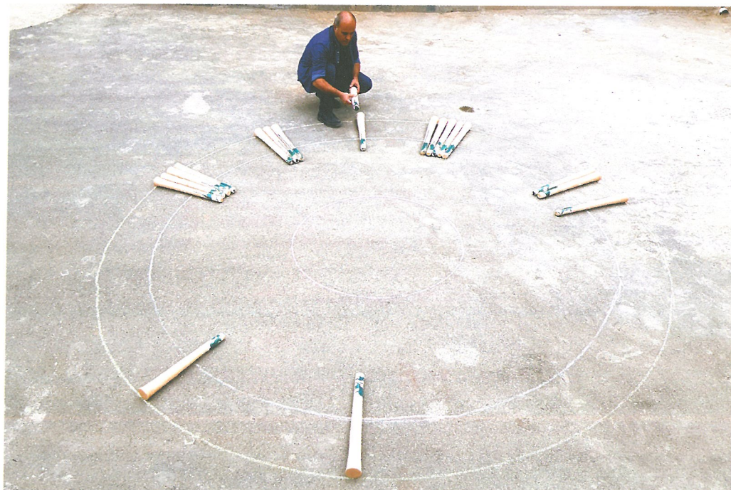
ساخت الگو برای نحوه قراردادن میخ‌های جدید سفالی به عنوان طبقه در کوره Making a model for inserting the earthenware bars functioning as shelves in the kiln
