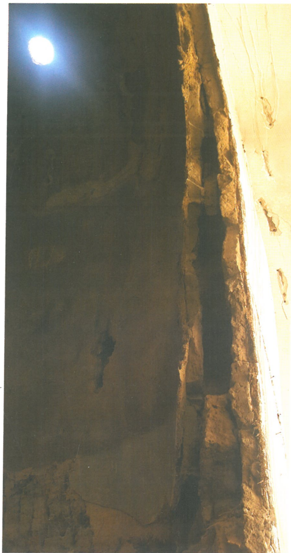
محل اتصال دیوار کوره با دیوار اتاق خانه The point where the kiln wall joined the room wall
