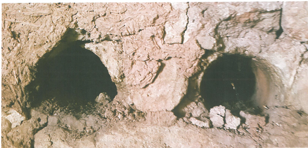
نمایی بعد از لایه برداری کاهگل
