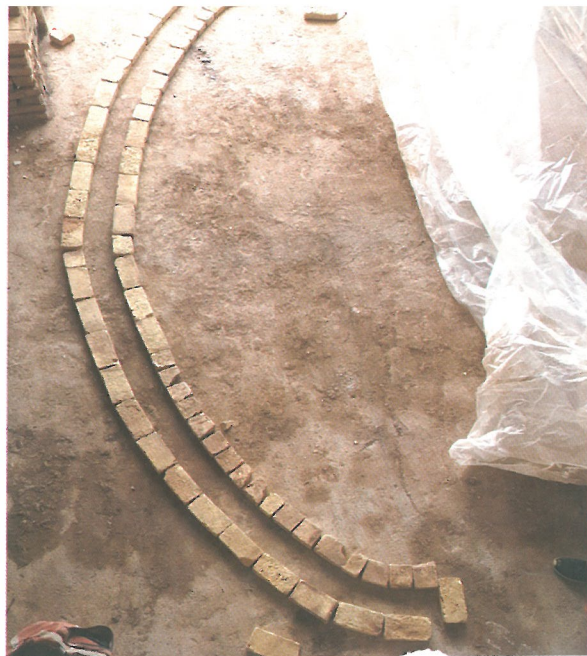
ساخت الگو برای بازسازی سقف آتش‌دان Making a model for building the fireplace ceiling
